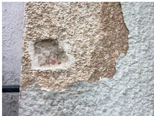
F-1. P. Višinskio g. fasadas, II a. sienos plokštuma. Randamas autentiškas dažymas. Zondažas Z-1. SL-1.
