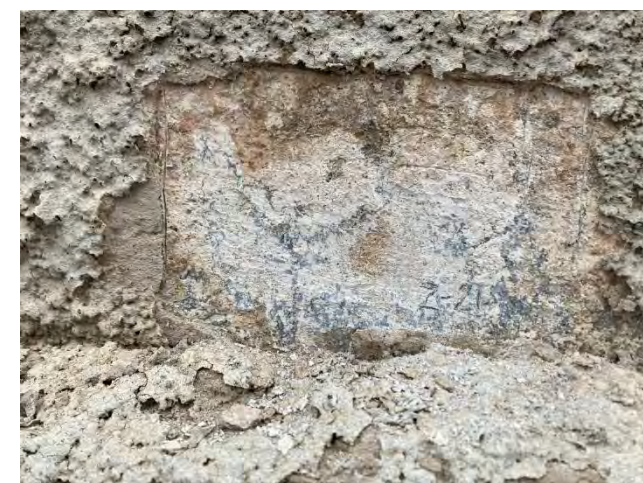
F-25. Užapvalinto kampo dekoru I a. fragmentas. Autentiško dažymo pėdsakai. Zondžas Z-21. SL-1.
