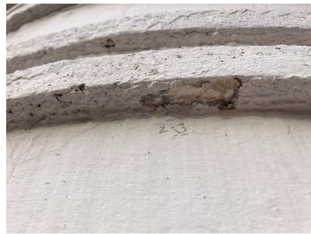
F-3. P. Višinskio g. ir Žemaitės g. užapvalinto kampo dekoru elementas, II a. Autentiško dažymo pėdsakai. Zondažas Z-3. SL-2.
