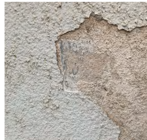
F-12. P. Višinskio g. fasado I a. sienos plokštuma. Autentiško dažymo pėdsakai. Zondažas Z-11. SL-1.
