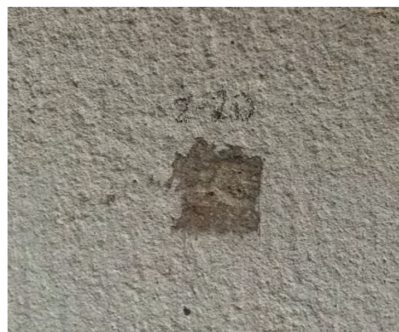
F-23. Kiemo fasado I a. sienos plokštumos fragmentas. Randami autentiško dažymo likučiai. Z-20. SL-1.
