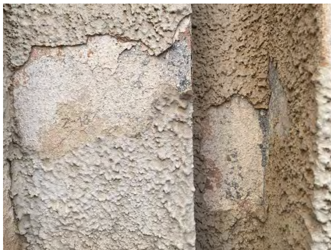
F-14. P. Višinskio g. fasado pagrindinio įėjimo I a. dekoro elementas. Autentiško dažymo pėdsakai. Zondžas Z-13. SL-2.
