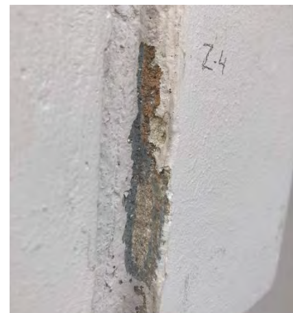
F-4. P. Višinskio g. fasadas, II a. balkono lango dekoratyvinio apvado fragmentas. Autentiško dažymo pėdsakai. Zondažas Z-4. SL-2.
