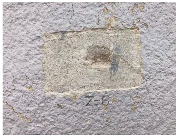
F-6. P. Višinskio g. ir Žemaitės g. užapvalinto kampo fragmentas, II a. Autentiško dažymo pėdsakai. Zondažas Z-6. SL-1.
