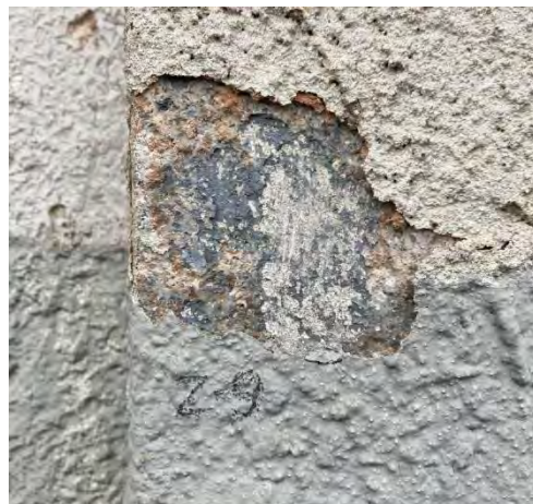
F-9. P. Višinskio g. fasadas, II a. balkono lango dekoratyvinio apvado fragmentas. Autentiško dažymo fragmentai. Zondažas Z-9. SL-2.
