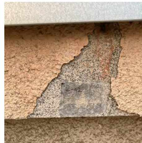
F-13. P. Višinskio g. fasado I a. lango dekoru elemento fragmentas. Autentiško dažymo pėdsakai. Zondažas Z-12. SL-2.
