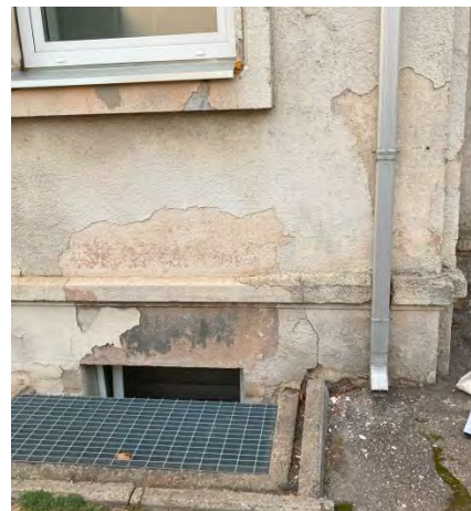
F-11. P. Višinskio g. fasadas. Cokolio atodangoje matomi autentiško dažymo fragmentai. Zondažai Z-11 ir Z-12.
